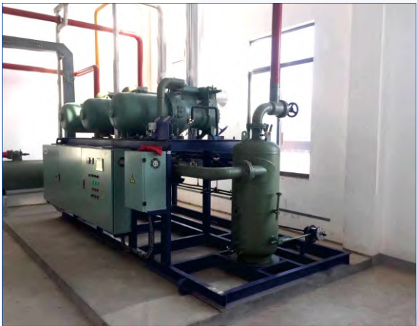
▲ 制冷机组的安装
