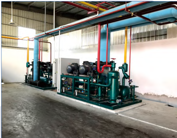
▲ 制冷机组的安装
